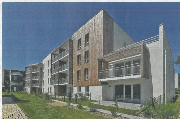
Avec ses 31 logements, la résidence Echappée belle, à Sarzeau, propose une offre accessible et adaptée aux besoins locaux.
